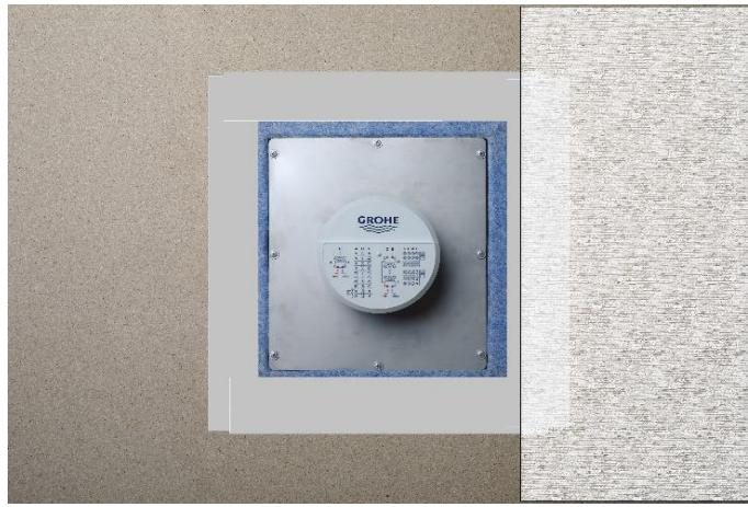
4- Applicera Mira 4400 multicoat på väggen. Var noga med att täcka hela remsan och skarven mot den blå fabriksmonterade manschetten.
