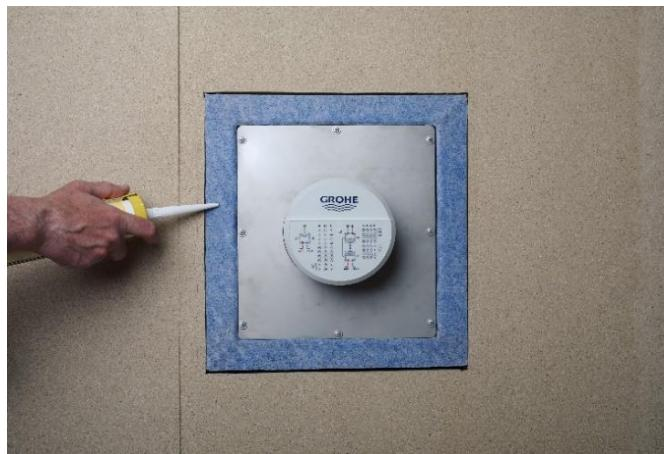
2 – Applicera Mira 3690 one-seal på ramens prefabricerade foliefläns och på väggytan som remsan skall täcka.
